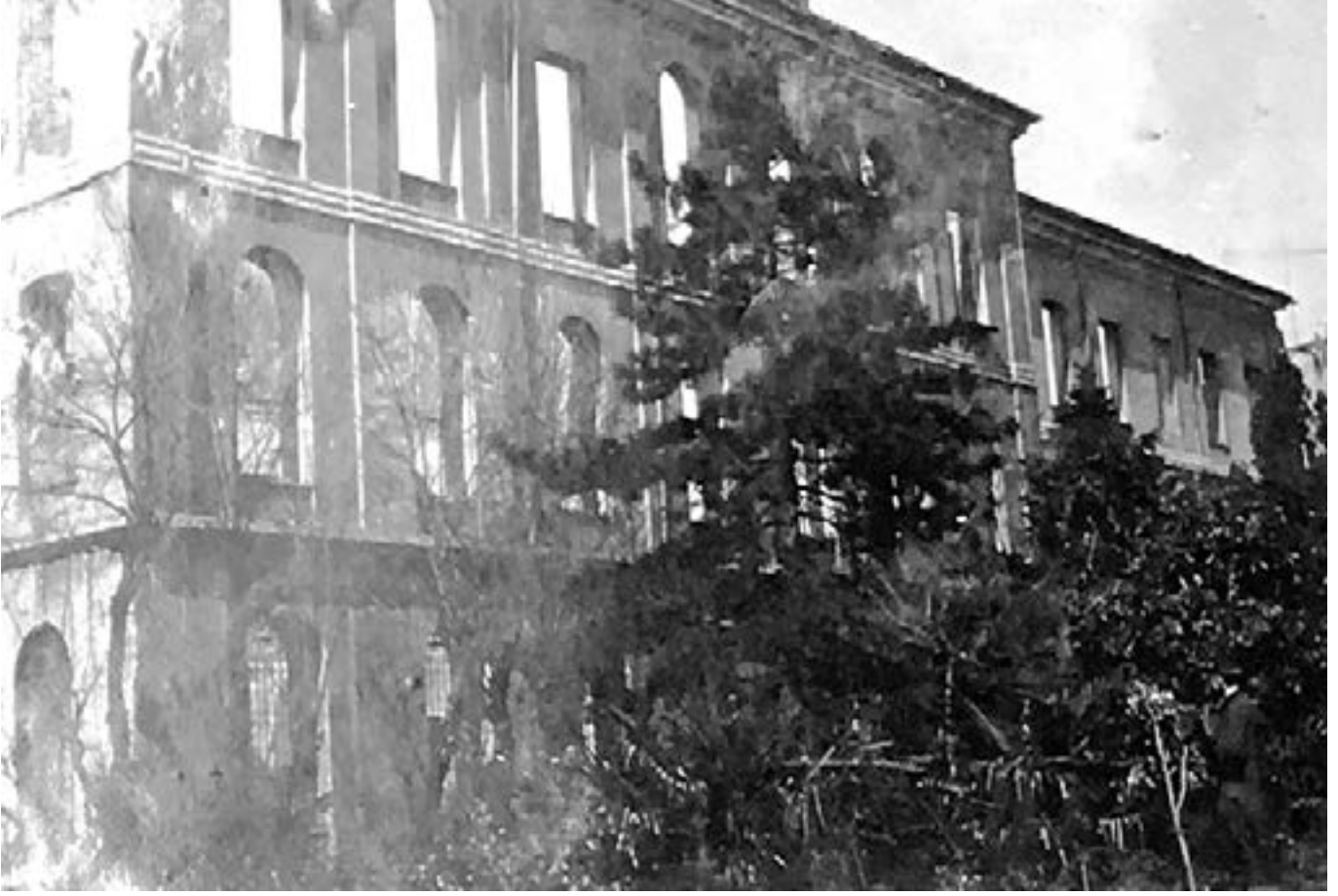
1907 yangınından sonra Galatasaray binası.
